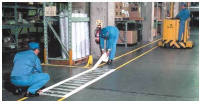
工場内施工例
